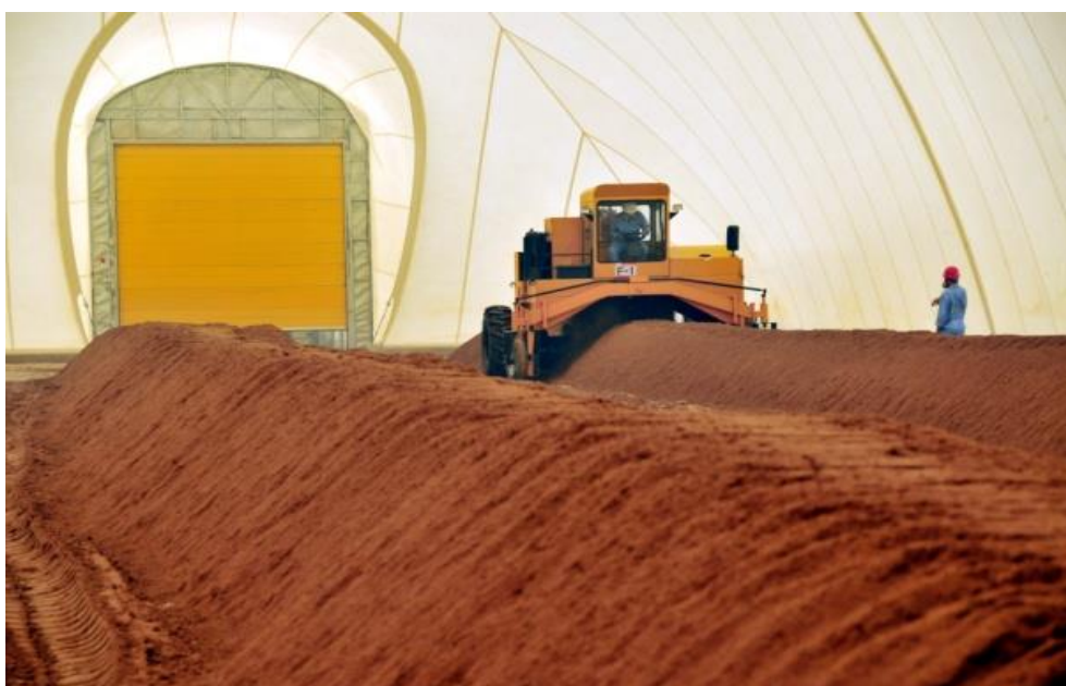
图 4.5-6 北京某氯碱化工场地修复工程—污染土壤翻抛修复过程
