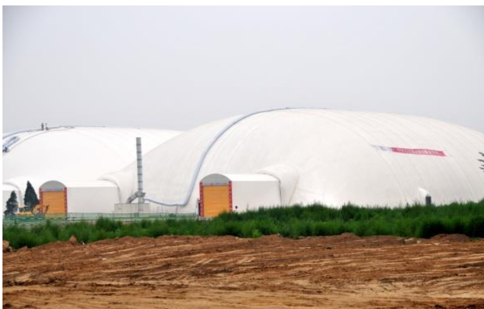
图 4.5-5 北京某氯碱化工场地修复工程—空气膜结构密闭修复大棚
