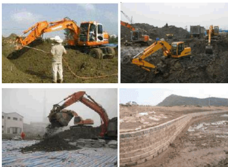
图 4.5-9 固化/稳定化技术现场实施
